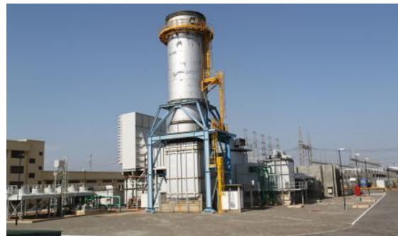
110MW TTPC1 and 80MW TTPC 2 Thermal Plants
